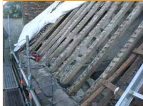
Les chevrons de la toiture ( versant nord )
