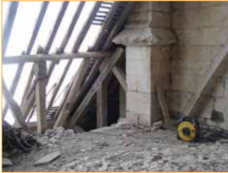
Le contrefort du clocher
